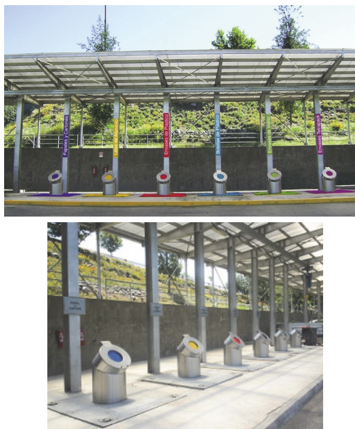
Imagen A.19 Contenedores subterráneos en punto limpio
