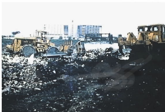
Imagen A.29 Relleno Sanitario La Feria, 1980
