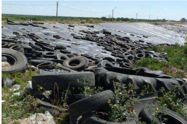
Impermeabilización con membrana PEAD
