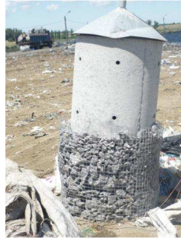
Conducción del biogás
