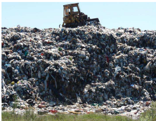
Residuos sin cobertura
