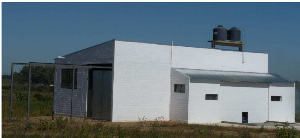
Vista de la planta
