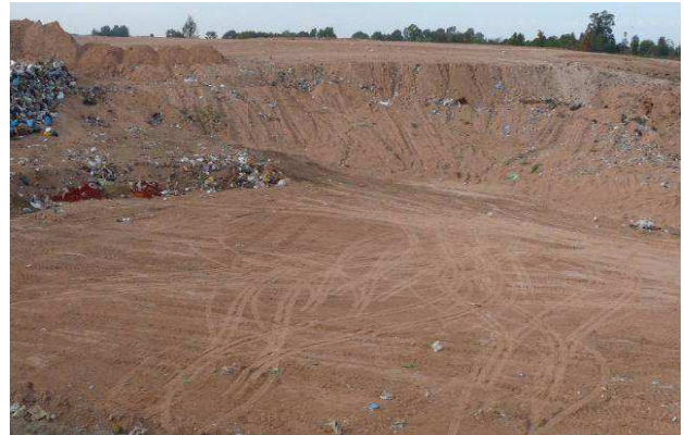
Impermeabilización con arcilla
