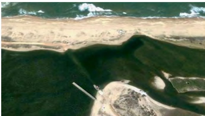
Puente inconcluso sobre la Laguna Garzón y la playa oceánica. Fuente: Google-earth
